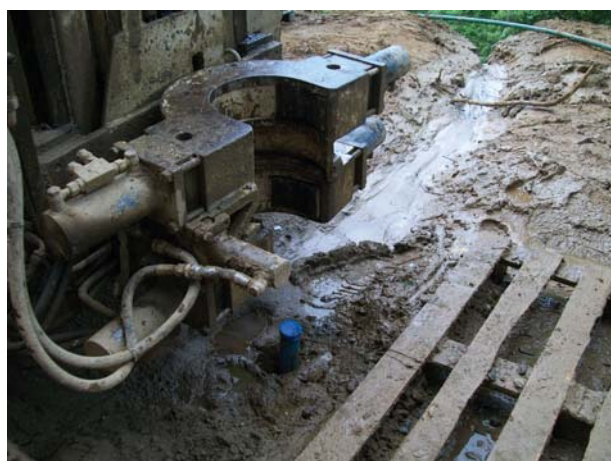
Foto 9: Un piezometro installato
