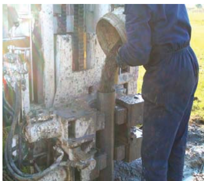
Foto 10: formazione del filtro drenante con ghiaietto siliceo
