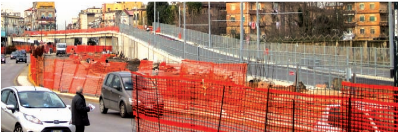
Rampa di collegamento della Perimetrale di Scampia con viale U. Maddalena
