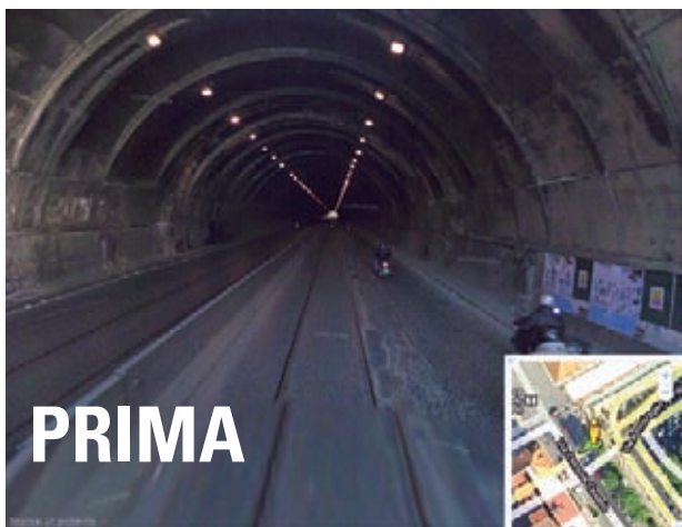
Manutenzione straordinaria della Galleria della Vittoria
