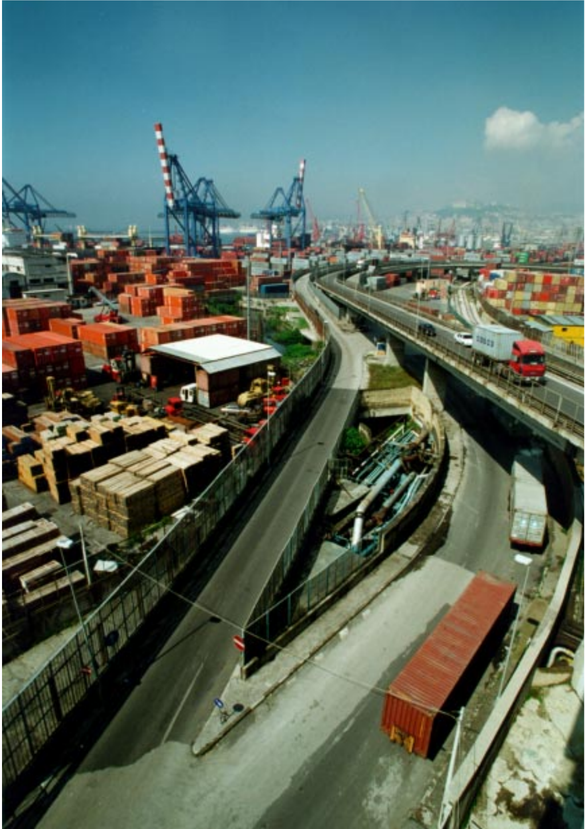
Fig.30. Svincolo autostradale del porto a calata Pollena .
