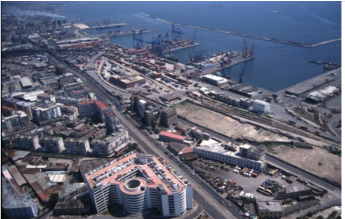
Fig.29. Veduta di S. Erasmo e del porto commerciale, in primo piano l'auto-silos di via B. Brin.
