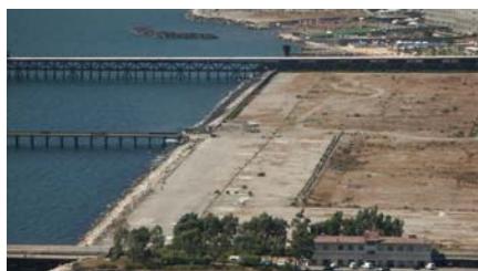
vista della colmata
