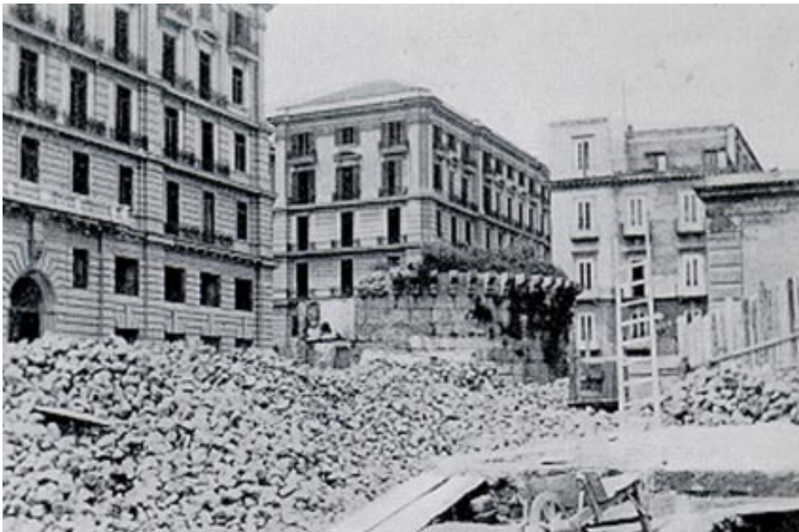
Fig.6. Demolizione delle mura aragonesi per realizzare la piazza della ferrovia.
