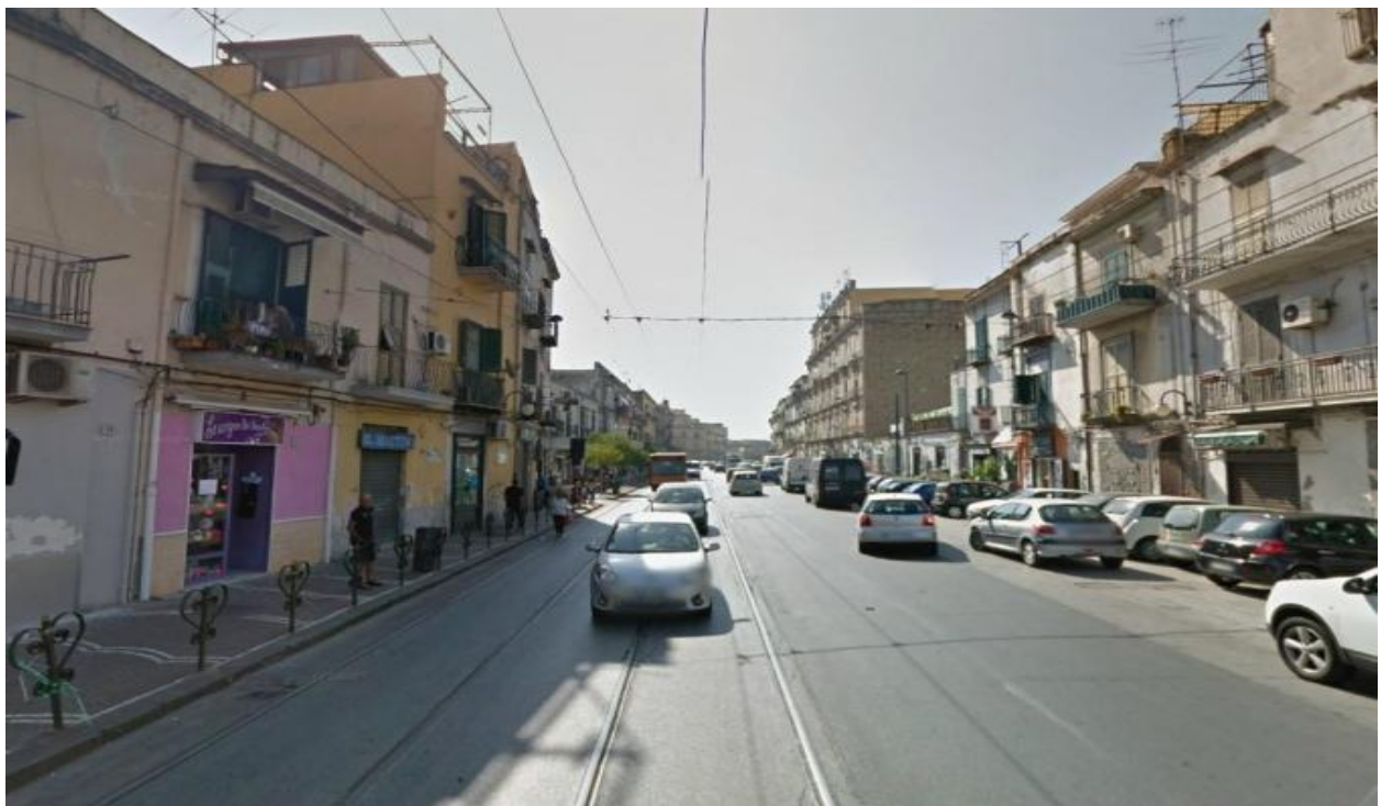
Corso San Giovanni, tratta compresa tra via Pazzigno e largo Tartarone, con binari in accosto al marciapiede lato monte
