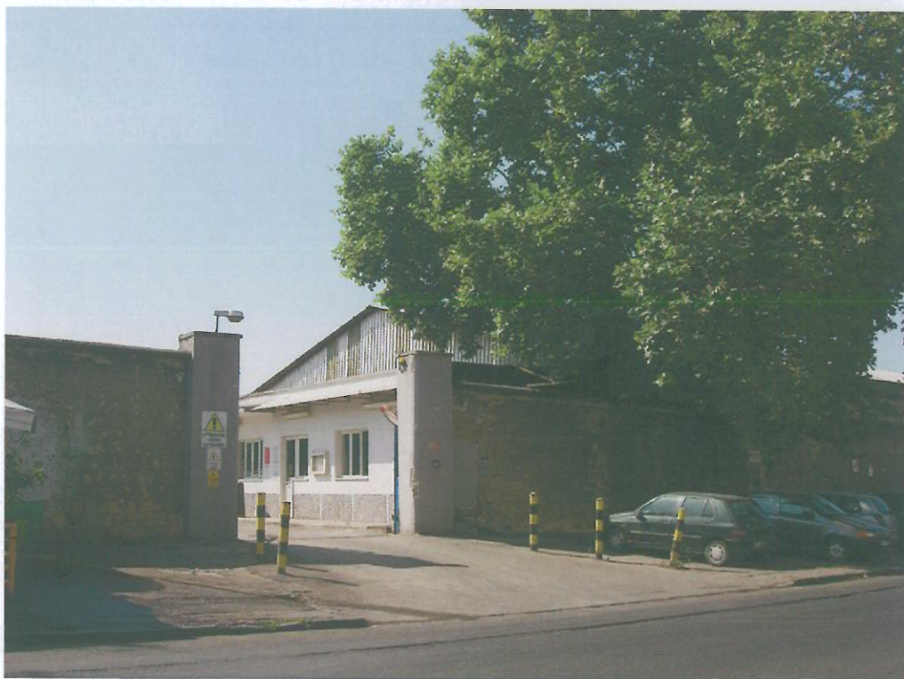
Foto 4: Ingresso dell'area in oggetto su via Provinciale delle Puglie.
