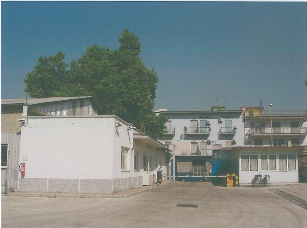
Foto 5: Ingresso dell'area in oggetto lato interno.
