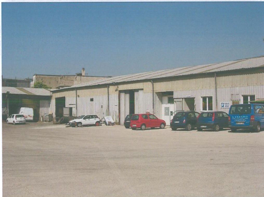
Foto 10: Interno dell'area in oggetto. Vista dell'edificio esistente.
