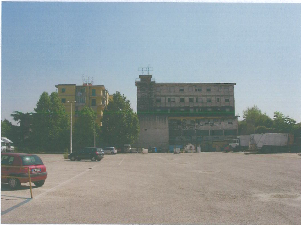
Foto 8: Interno dell'area in oggetto.
