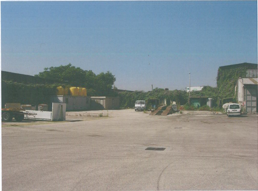
Foto 11: Interno dell'area in oggetto.
