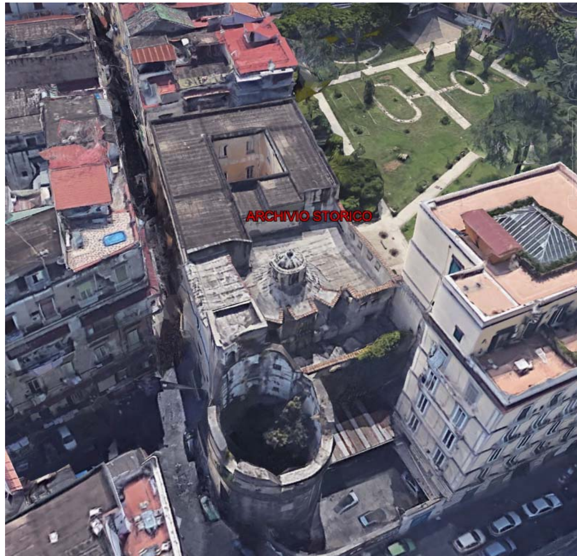
fig. 2 - vista aerea del complesso edilizio
