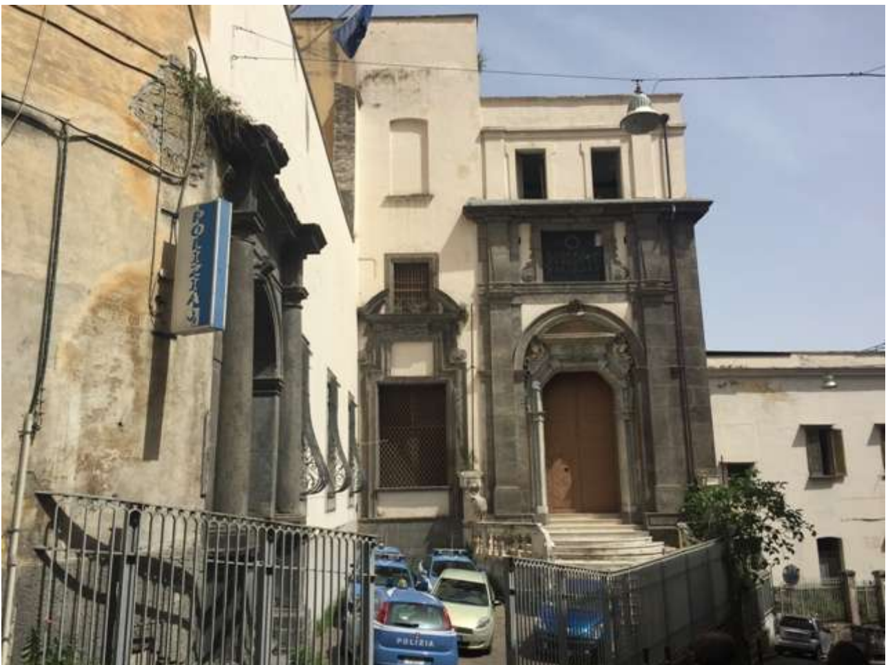
Ingresso all'edificio D e alla chiesa da vico Trinità delle Monache
