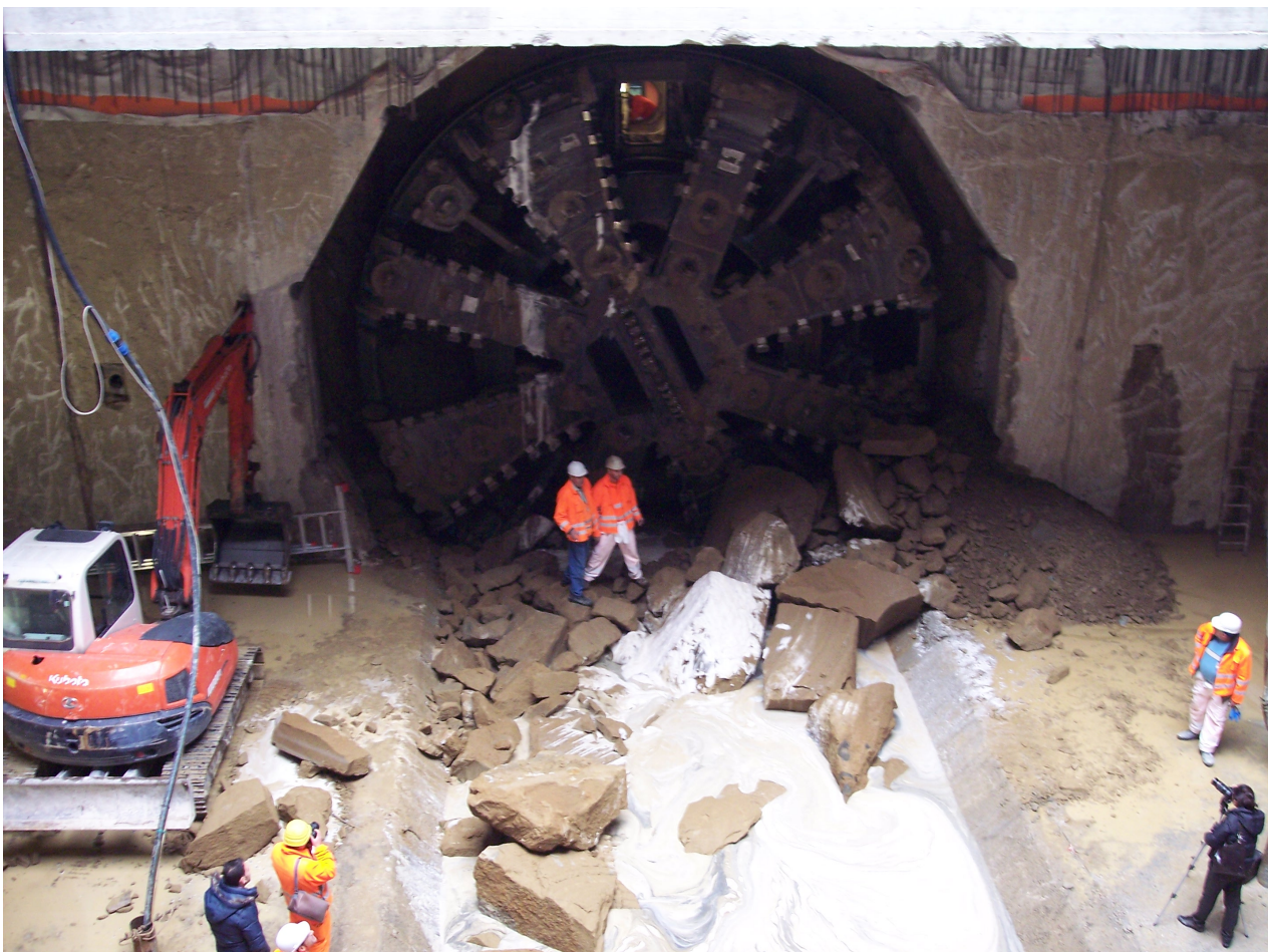
Figura 5.1.: Sfondo della TBM nel pozzo d'estrazione di P.za Municipio.
