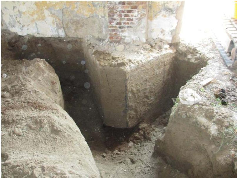
*Fig. 3.5 – Plinto al piede del pilastro perimetrale – Lato Est*
