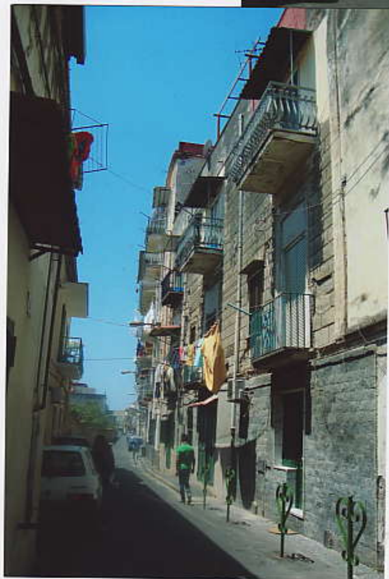
FOTO 6 Fabbricato su Via B.Quaranta
