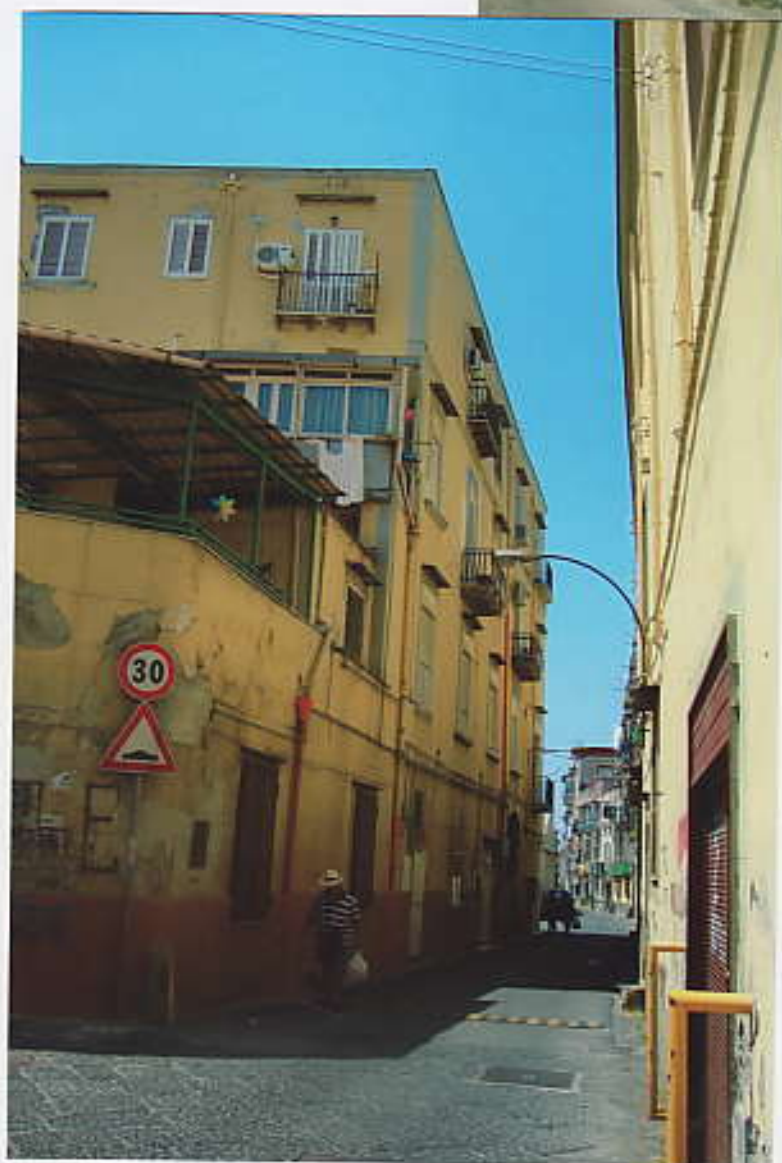
FOTO 4 Fabbricato su Via B. Quaranta incrocio di via Aviglione
