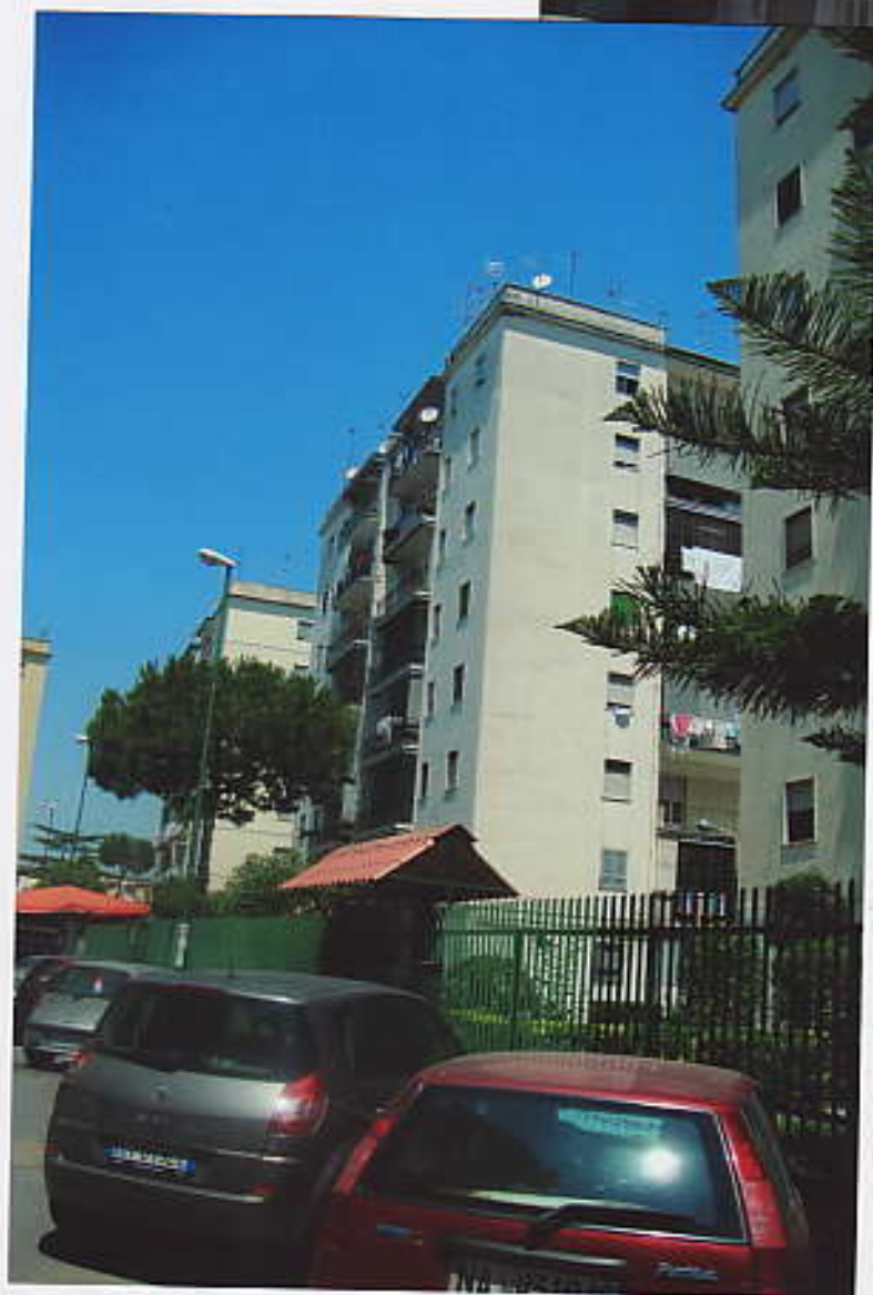
FOTO 10 Fabbricato su Via trav.Martirano
