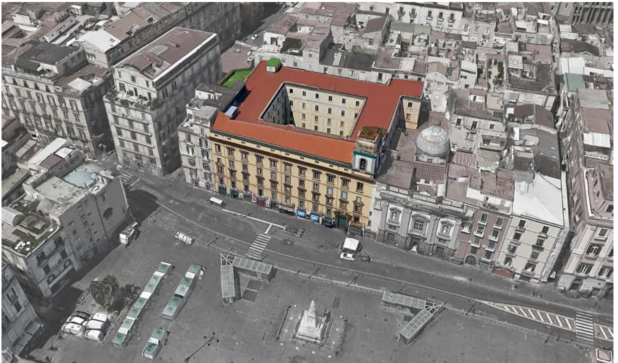
Figura 1 - Vista aerea con individuazione dell'edificio "ex anagrafe"
