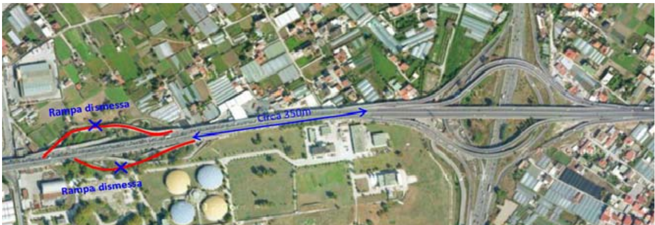
Figura 3.11 - Rampe dismesse che non saranno rifunzionalizzate
