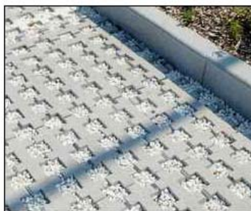
Figura 4.2 -Pavimentazione in massello autobloccante tipo "Carnia" di Magnetti intasato in pietrisco
