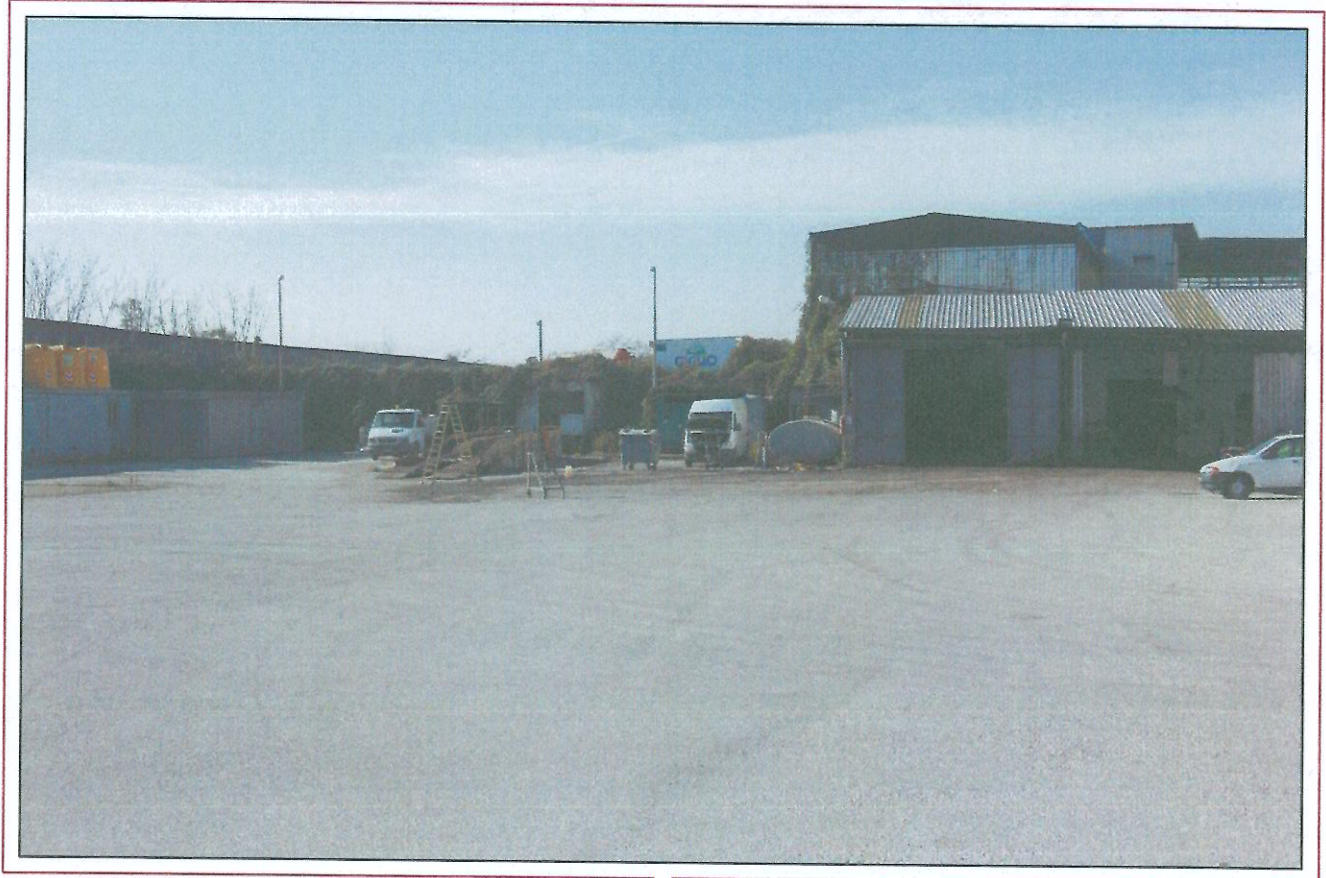
14. VISTA DEL PIAZZALE INTERNO CON CAPANNONE DA DEMOLIRE
