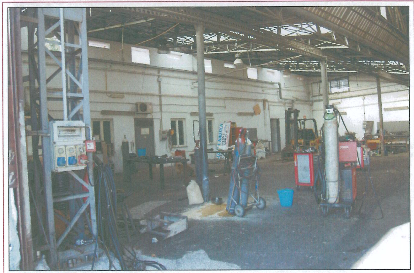
10. INTERNO DEL CAPANNONE DA DEMOLIRE
