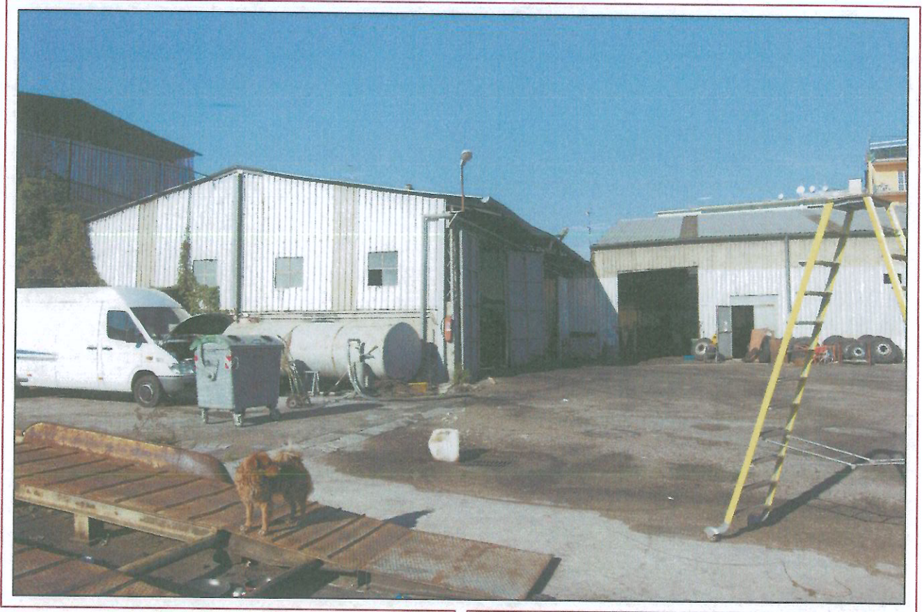
13. VISTA DEL PIAZZALE INTERNO CON CAPANNONE DA DEMOLIRE
