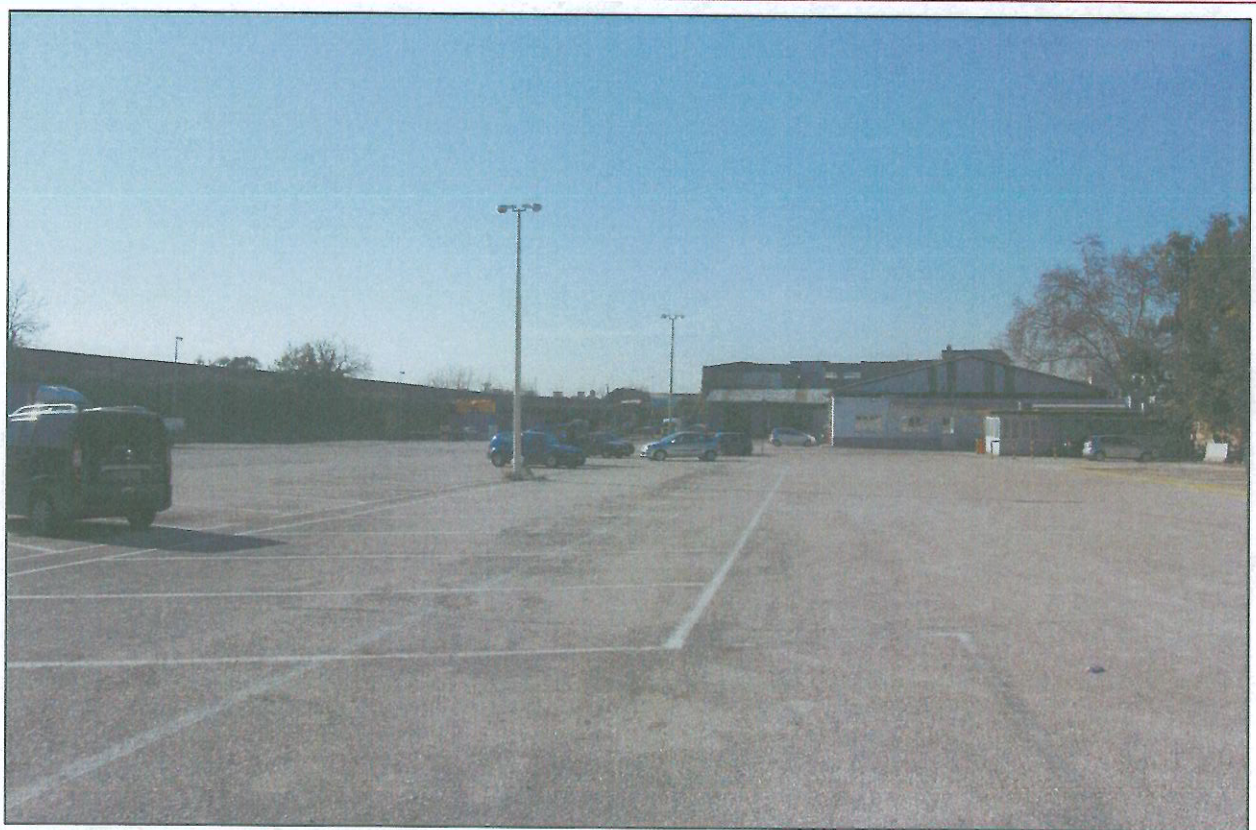
16. VISTA DEL PIAZZALE INTERNO CON CAPANNONE DA DEMOLIRE
