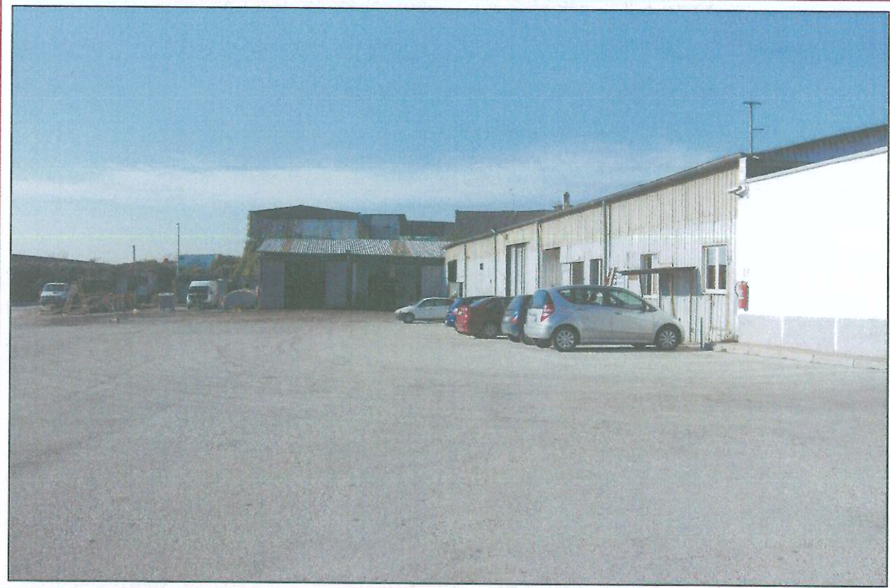
15. VISTA DEL PIAZZALE INTERNO CON CAPANNONE DA DEMOLIRE
