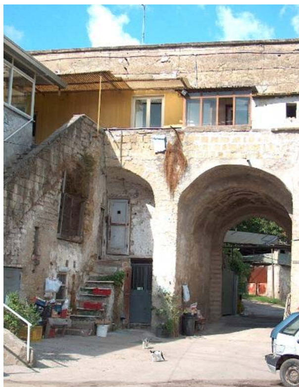
Ingresso alla Masseria Suarez e corte interna
