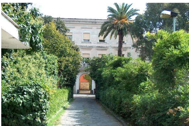
Villa Orefice: vista d'insieme, ingresso e teatro interno
