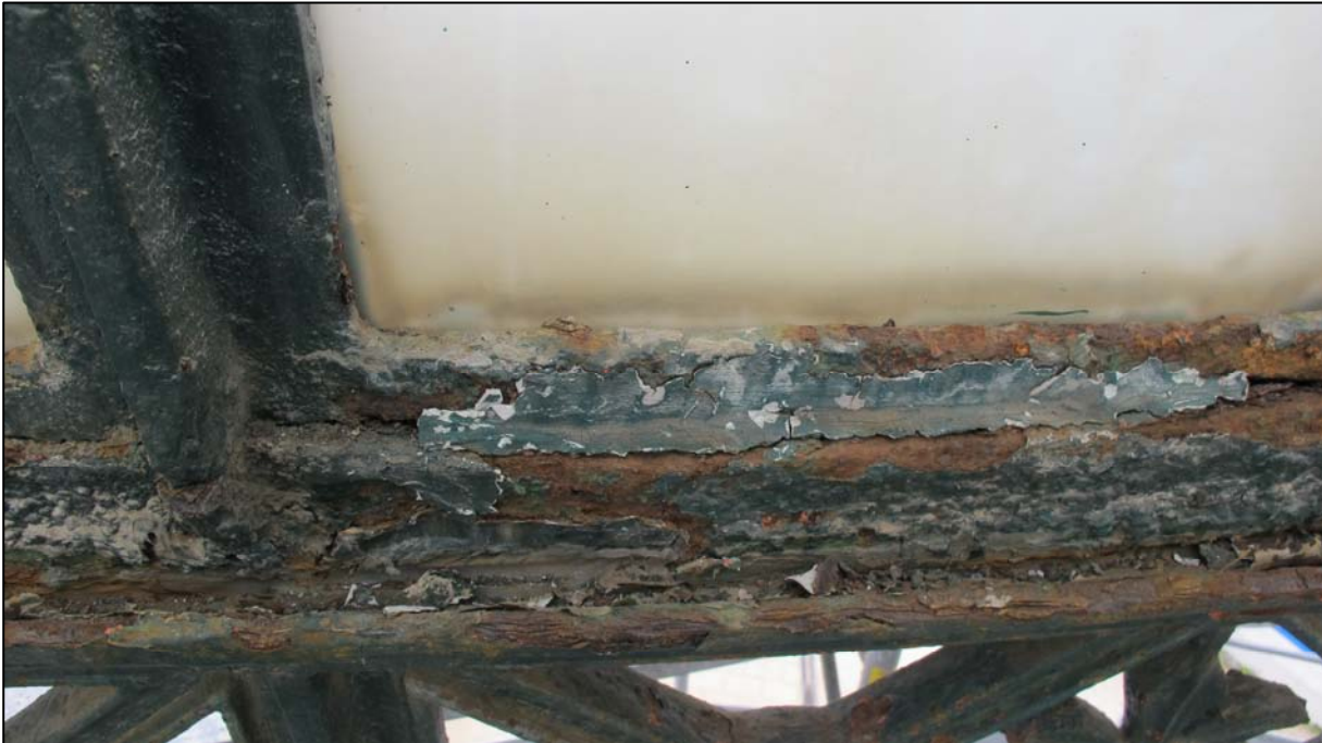
Particolare del degrado dei serramenti del tamburo vetrato
