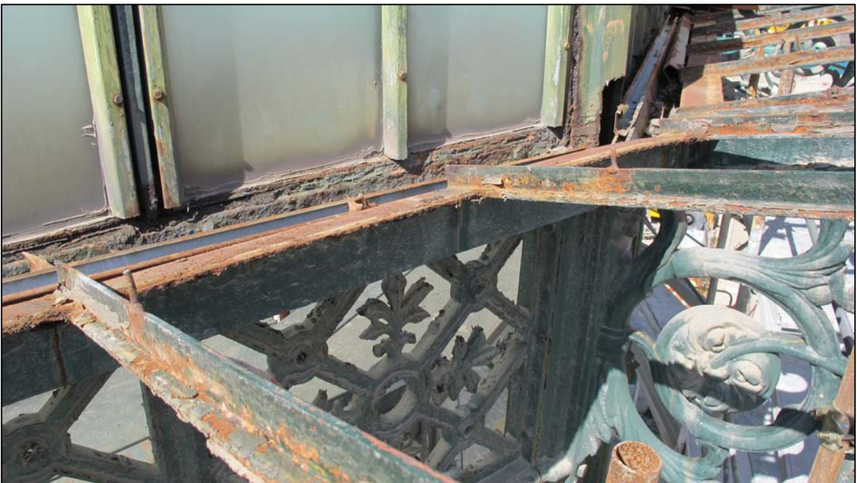
Particolare della struttura di supporto dei vetri della pensilina prima dello smontaggio
