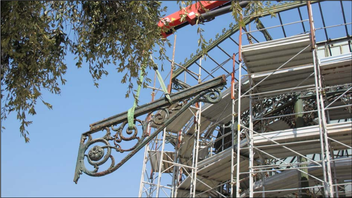
Calo in basso di un mensolone durante la fase smontaggio
