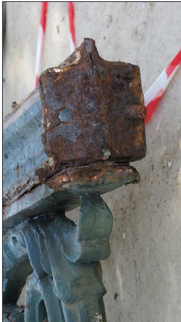
Dettaglio della testa della trave sopra mensola
