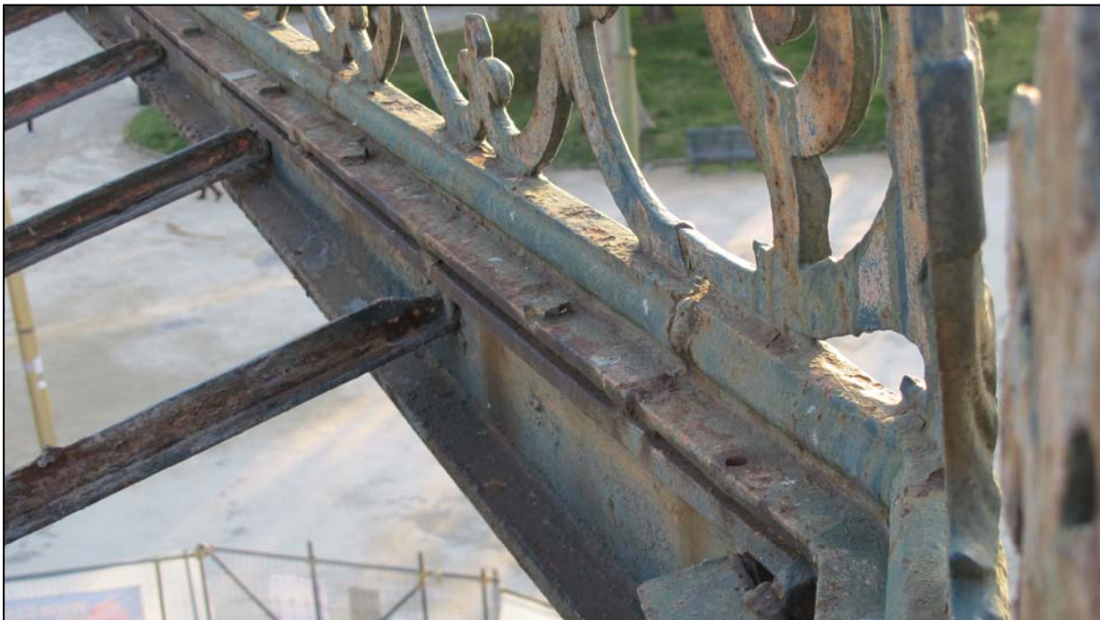
Trave perimetrale esterna di collegamento- Dettaglio dell'ancoraggio della fascia con decoro
