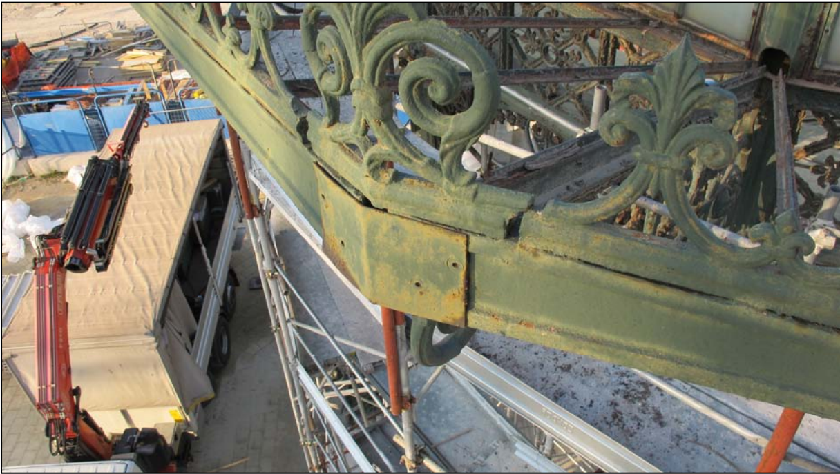
Piastra di collegamento delle travi perimetrali esterne della pensilina prima dello smontaggio
