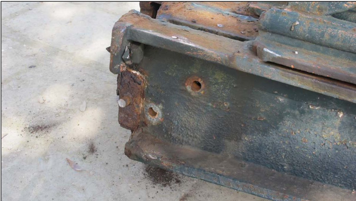
Dettaglio del sistema di ancoraggio del mensolone di sostegno della pensilina esterna
