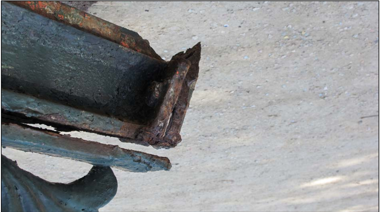
Dettaglio della testa della trave sopra mensola
