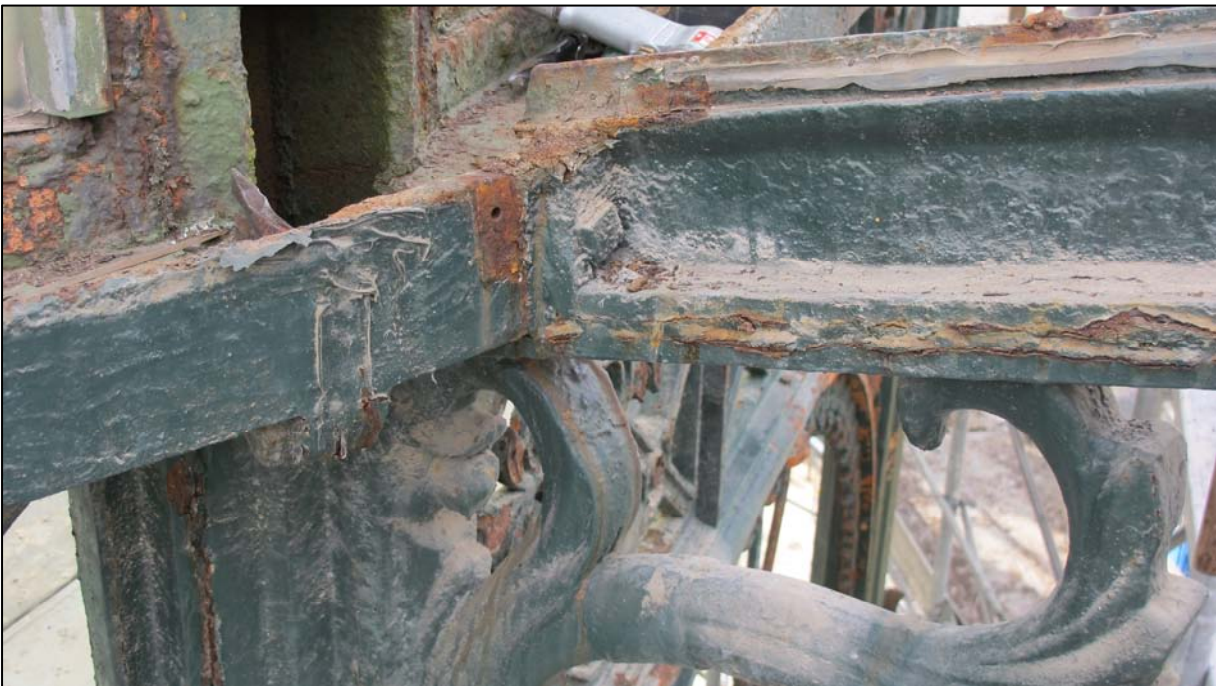
Particolare del sistema di ancoraggio dei mensoloni prima dello smontaggio
