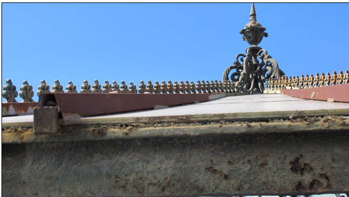
Copertura centrale – Dettaglio del profilo fermavetro
