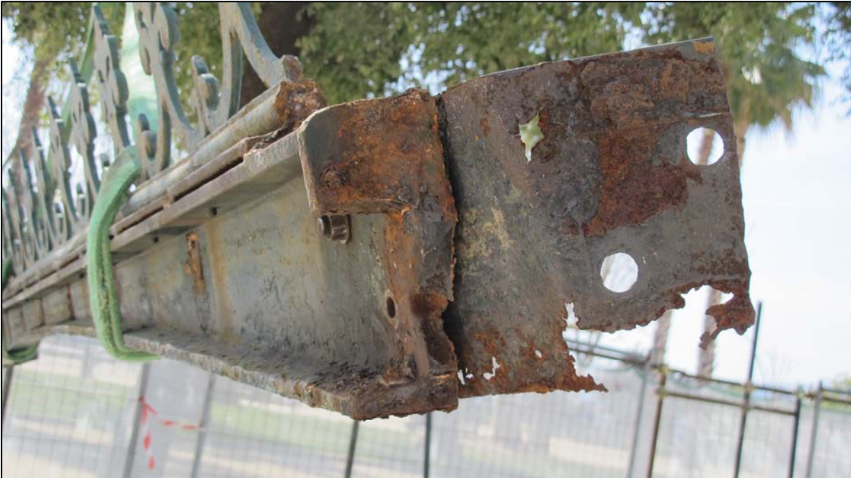
Particolare della piastra di collegamento delle travi perimetrali esterne della pensilina dopo lo smontaggio
