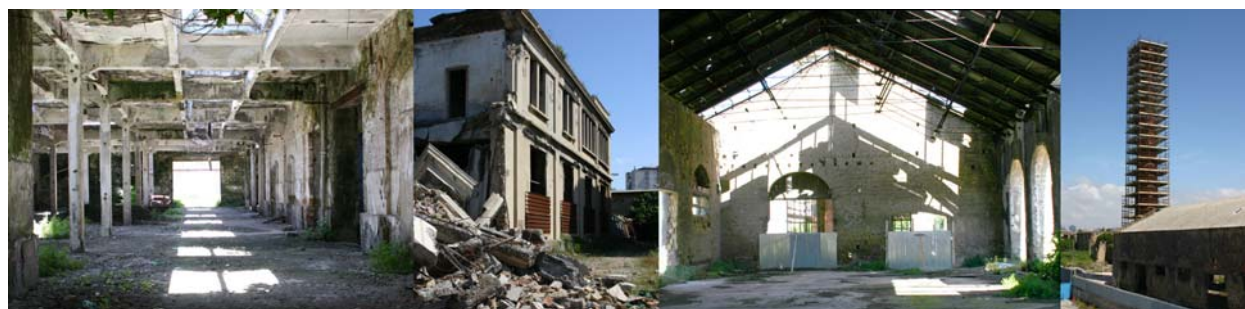
fig.5 Immagini di alcuni edifici della Corradini (ex concerie 1; uffici spedizioni 11; raffinaggio cubilotti 10; ciminiera 12)
