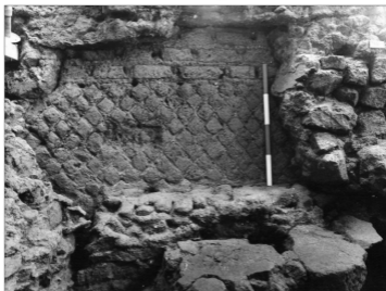
Fig. 7 – Muro in reticolato dell'isolato di età imperiale
