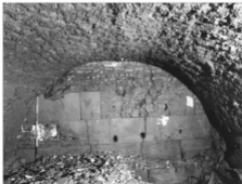
Fig. 5 – Muro in opera quadrata all'interno del cassinato del palazzo di età vicereale
