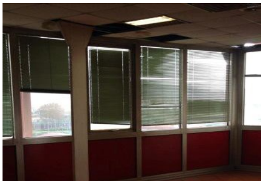
Stato di fatto della Palazzina A: quarto piano.
